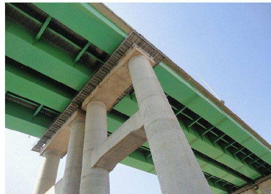
웅진대교 하부 전경
