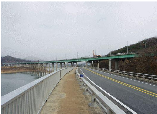
웅진대교 상부 전경
